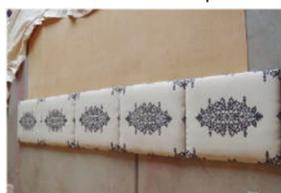
de madeira, na parte detrás. Em seguida, siga encapando as placas e madeira ou de MDF Logo após, com todas as placas encapadas, comece a fixar as plaquinhas na placa maior de madeira, com o auxílio de parafusos
