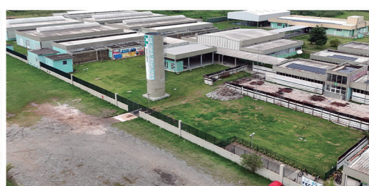
Ampliação do Instituto Federal de São Paulo
